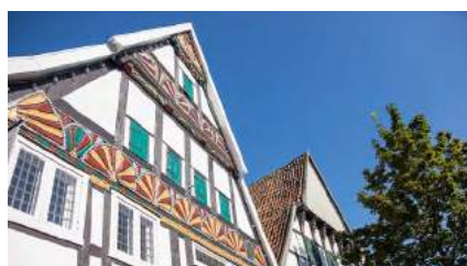
Fachwerkgiebel in Wiedenbrück
